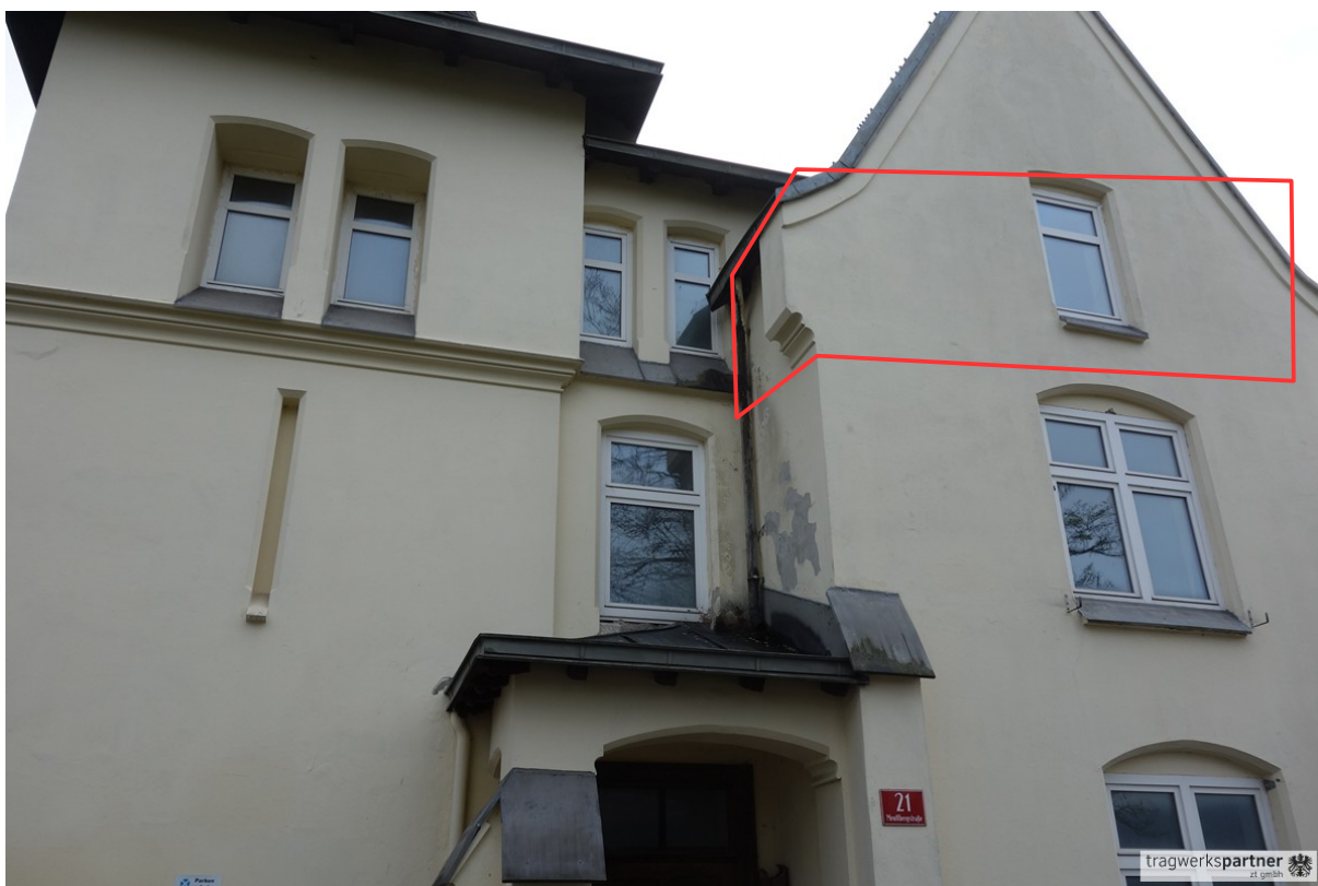
Abbildung 2: Außensicht Nordfassade – gegenständlicher Raum markiert
